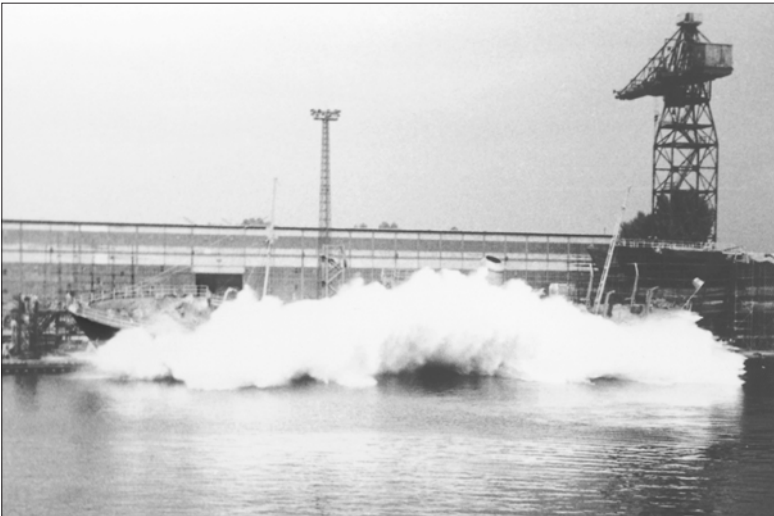
Поперечный спуск траулера. Сточня Гданьская. 1959 год. Фото автора
